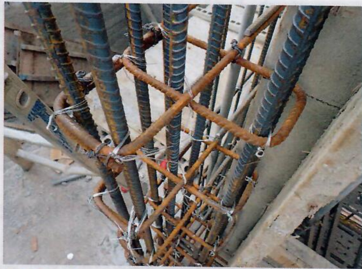
建築安全履歷在921地震和206地震後更顯重要，其中涉及實際鋼筋施工紀錄和結構力學，是消費者看不到的基礎，卻關係住戶的生命安全。圖為連續箍筋。中央社記者韋樞台北傳真105年5月22日
