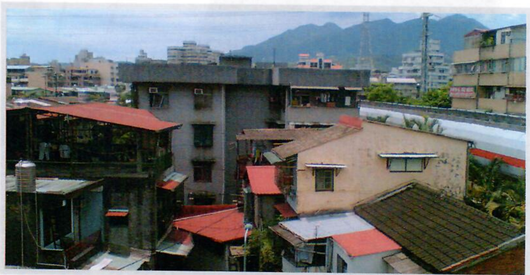
海砂屋、輻射屋可能吞噬健康，裝潢材料也可能隱藏危害人體的甲醛和有機溶劑，成為「無形殺手」。圖為台北市一處社區的民宅。此為示意圖，非問題住宅。(圖樂揚建設提供)中央社記者蔡怡杼傳真 105年5月22日
