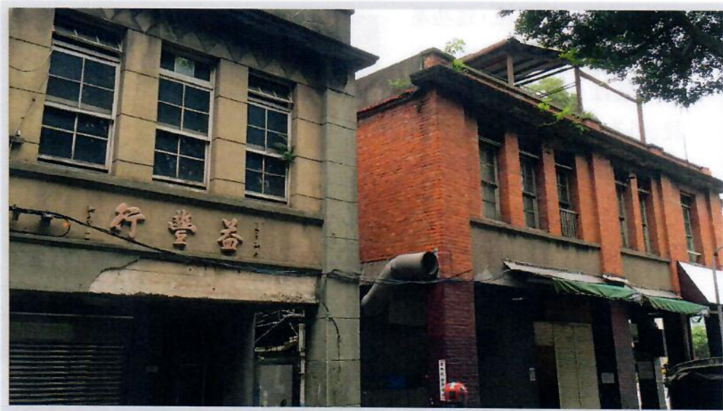
206強震震垮維冠大樓，也震出老屋耐震問題。全台30年以上老屋達370萬戶，政府將補貼非營利性的私有住宅執行健檢。圖為台北市大同區一處私有老宅。中央社記者陳政偉攝105年5月22日
